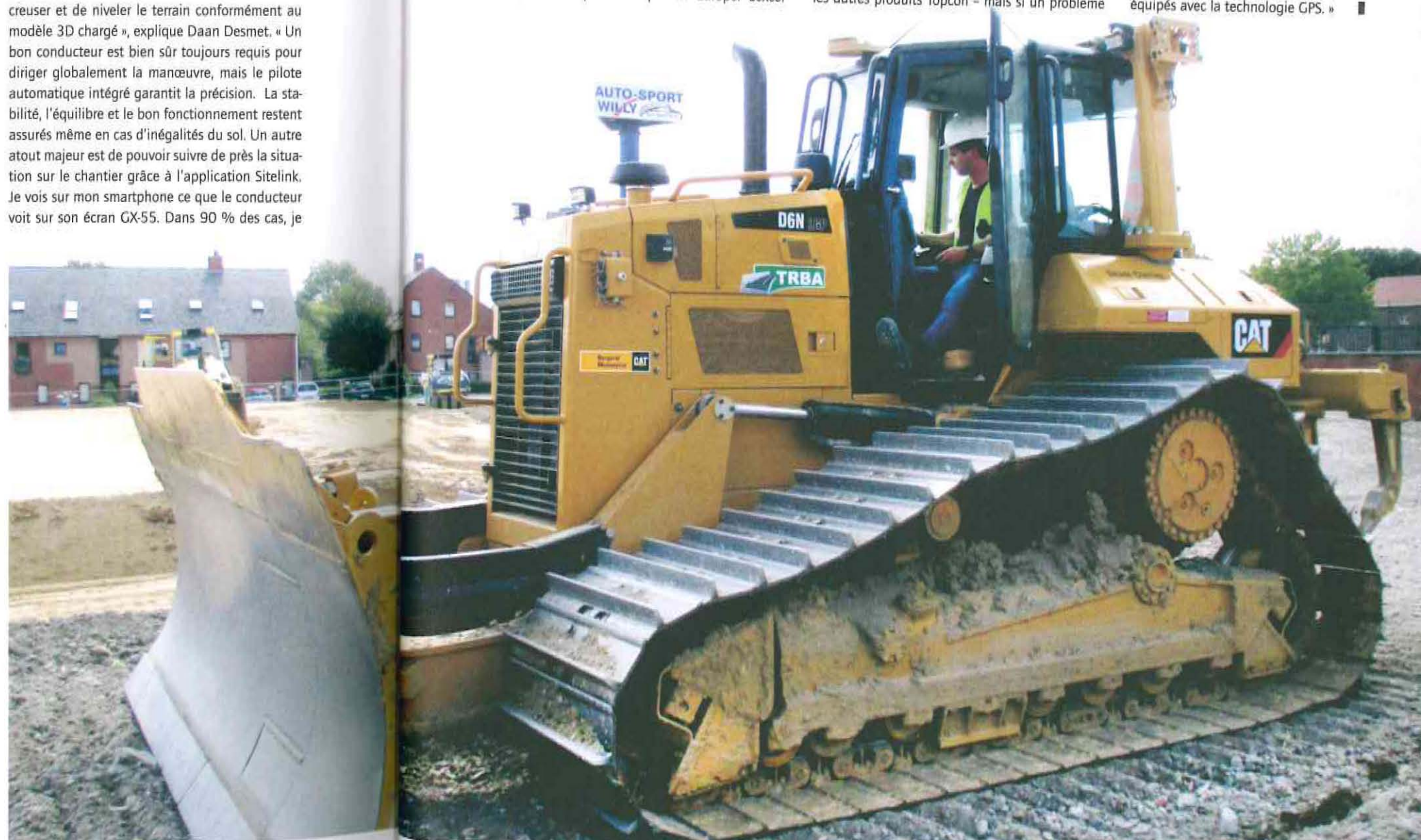
« Le matin, il suffit pour le conducteur de mettre le contact et le voilà parti, alors qu'il lui fallait avant d'abord grimper sur sa lame pour installer les antennes. »
